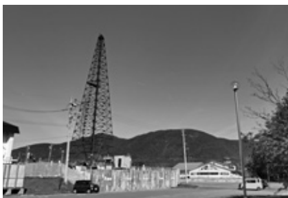
温泉掘削時のやぐら
