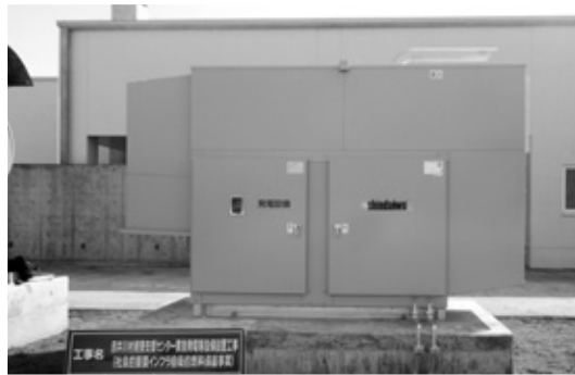
健康支援センター緊急発電設備設置工事 39,930千円
